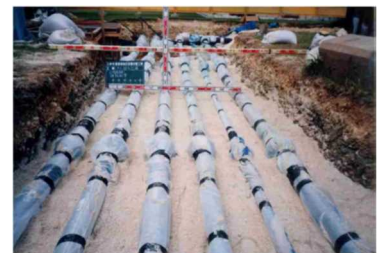
連結送水管（配管埋設イメージ）
